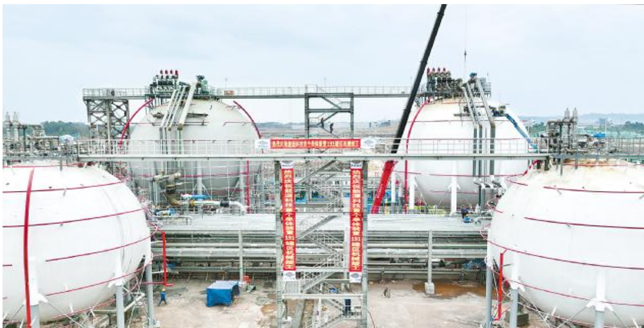
永祥能源科技首个单体装置191罐区机械竣工
